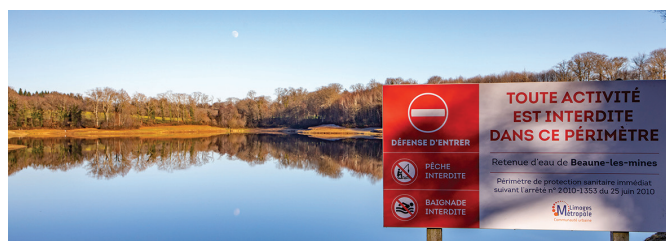
RETENUES DE BEAUNE 1 ET 2 • Utilisation : depuis 1951 Capacité utile de 2 millions de m 3 • Surface : 32 ha
