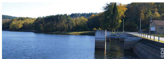
ÉTANG DE LA CROUZILLE • Utilisation : depuis 1926 Capacité utile de 1,4 million de m 3 • Surface : 42 ha
